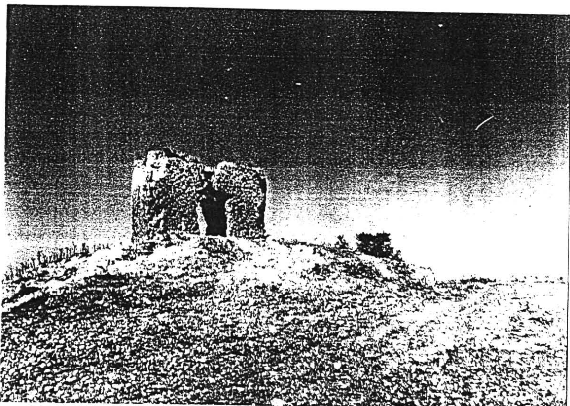
Foto sopra : Il cumulo di detriti che si intravede sotto i resti della Torre nascondono i resti del palazzo dove morì Federico Secondo di Svevia.
