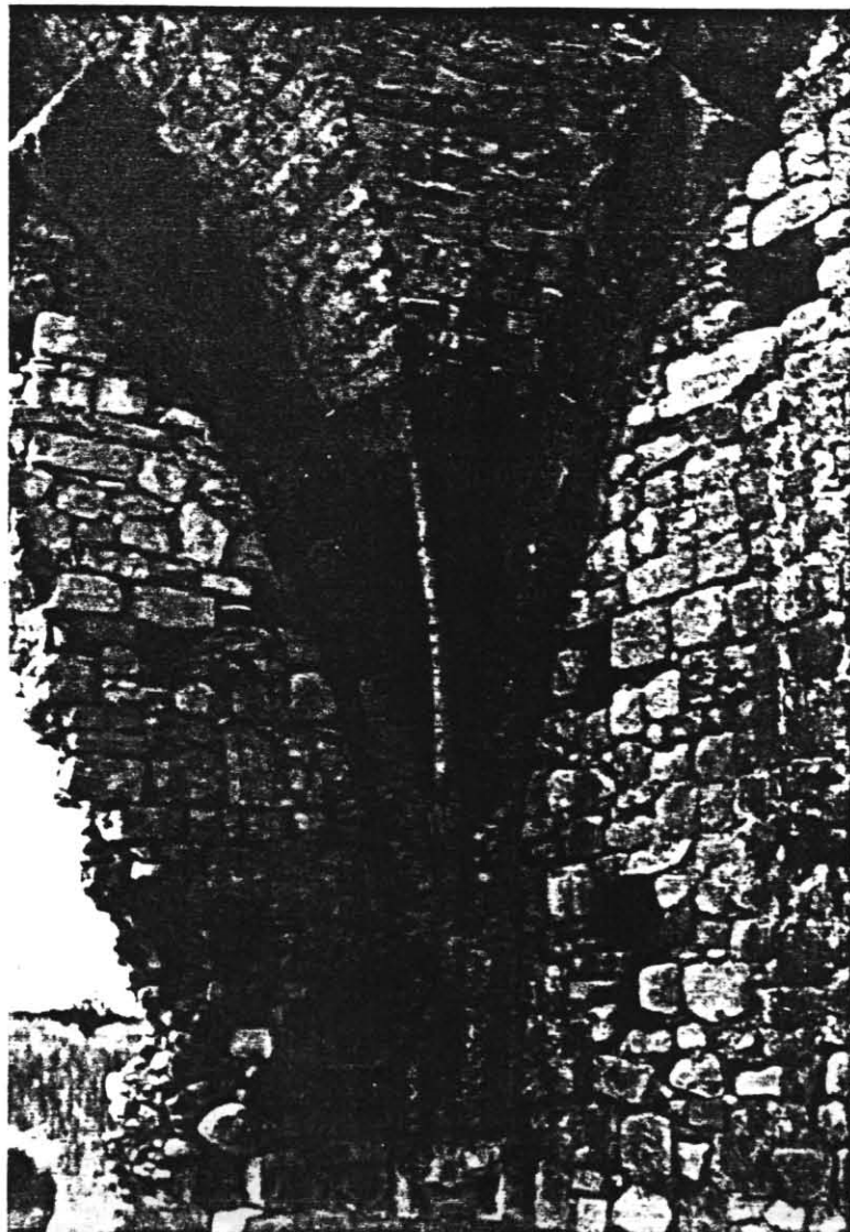
FOTO 23- LA BASE DEGLI ARCHI EST E SUD. SONO ANCORA VISIBILI LASCIATI DALLE IMPALCATURE USATE DAI COSTRUTTORI.
