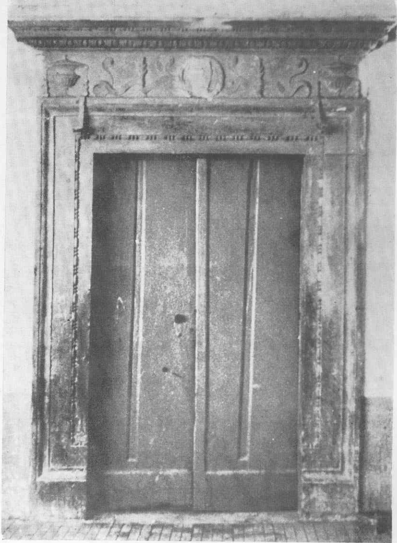
Fig. 24 — PORTALE della vecchia Sala del Trono, con Fregio e Stemma.
