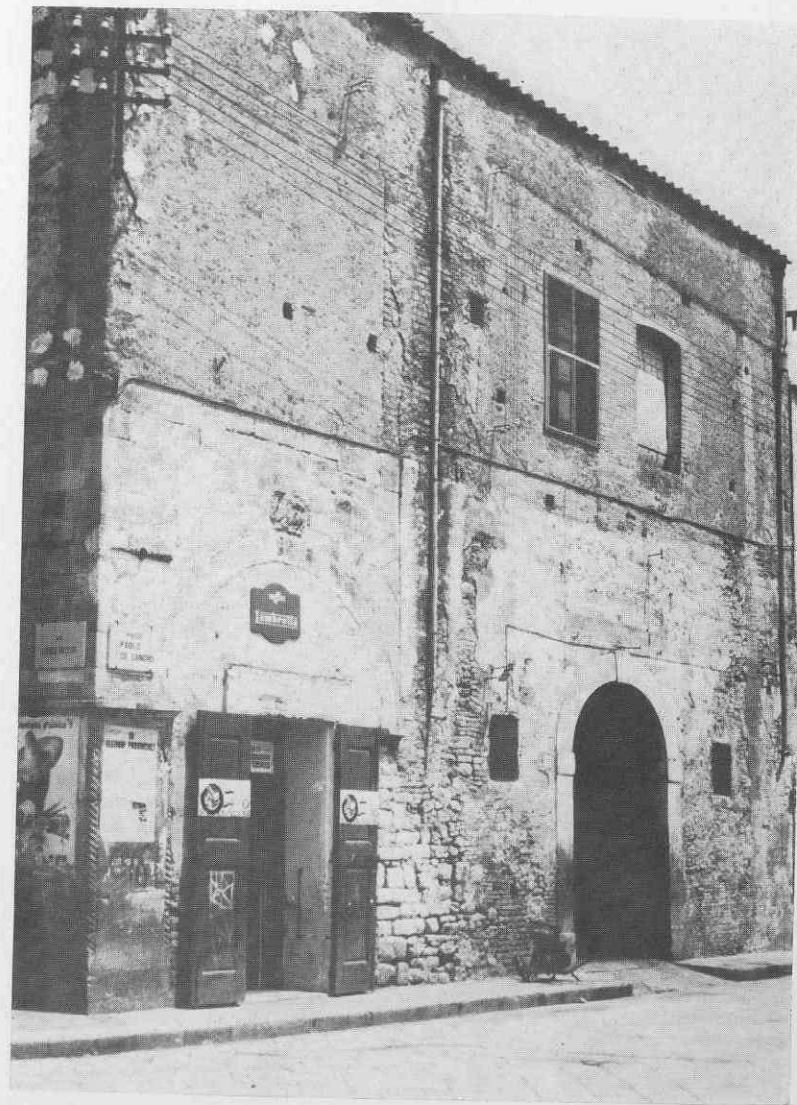
Fig. 30 — Il TEATRO di Sangro, visto dalla piazza, con le finestre, lo stallatico, il fregio sull'arco e le colonnine.
