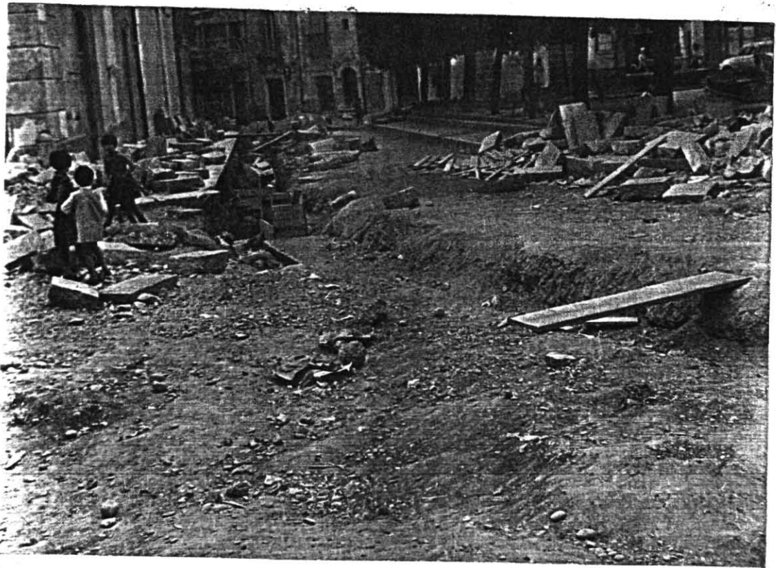
Piazza Antonio Gramsci o Largo di Santa Maria durante i lavori di costruzione della fogna bianca onde consentire alle acque piovane di defluire nel canale di scolo dell'Inferriata.
