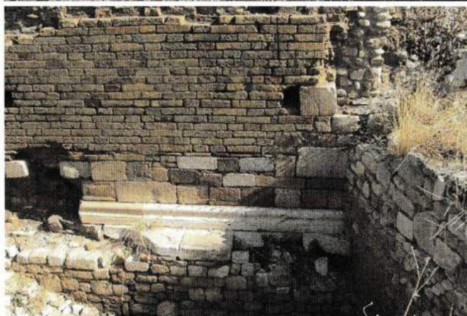
L'interno della torre
