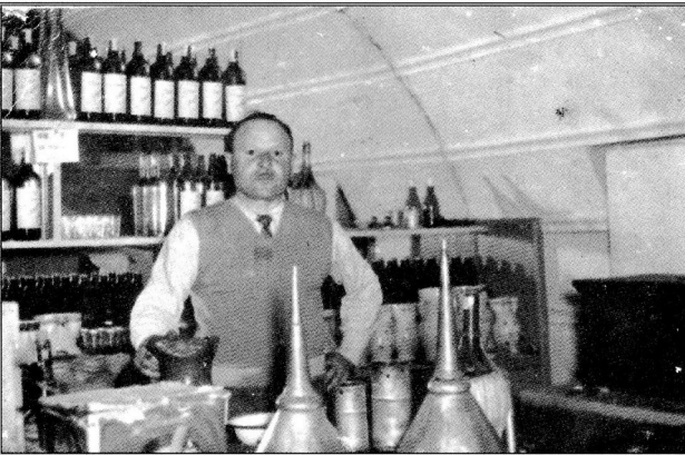
Foto 5. Interno della cantina Pagliaro.
