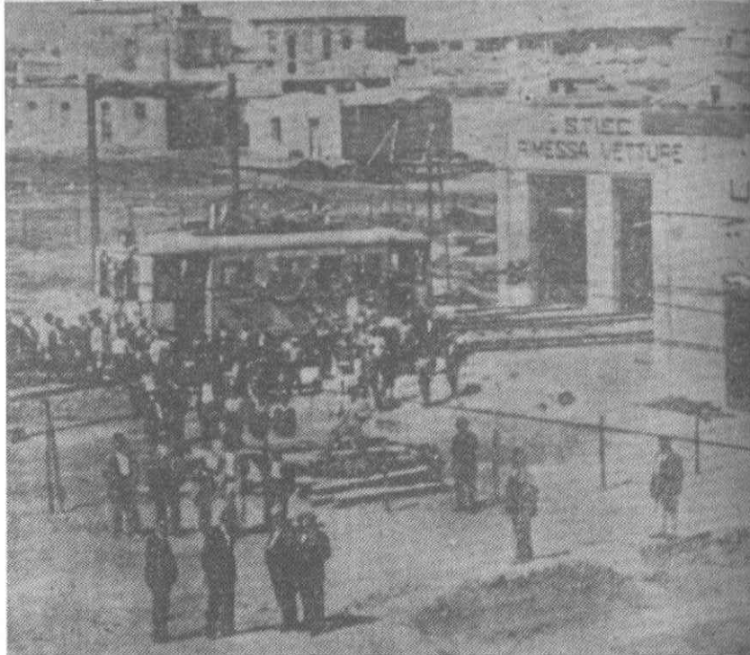
Il titolo, con foto, dell'articolo dedicato all'inaugurazione della tranvia de «La Gazzetta di Puglia» del 30 agosto 1925.
