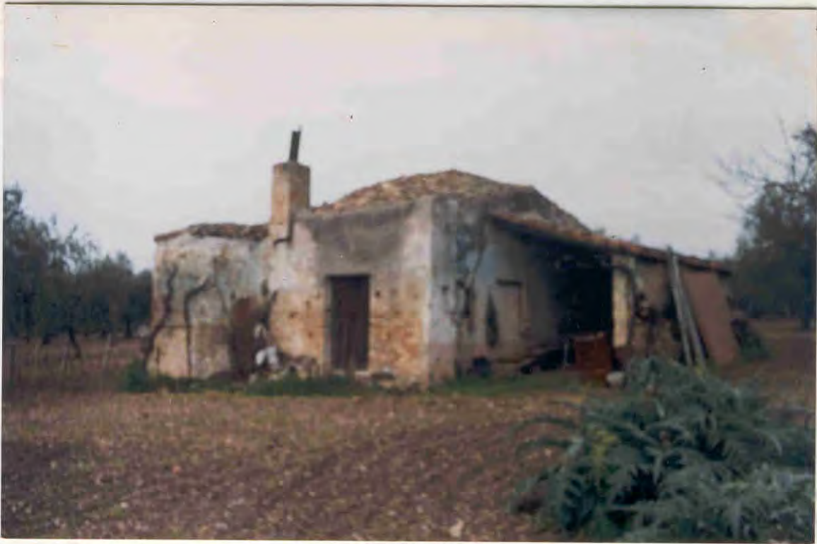
Foto sopra : Il fabbricato della masseriola " La Signorella d'Ametta " nella omonima contrada. E' l'unica costruzione rimasta presso il sito di Cantigliano.
