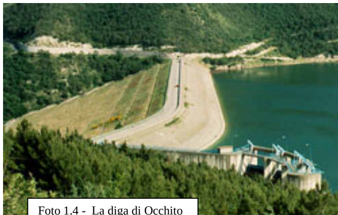
Foto 1.4 - La diga di Occhito
