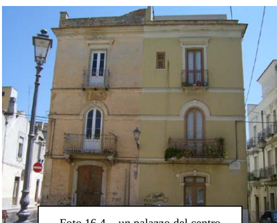
Foto 16.4 - un palazzo del centro storico (Piazza Raimondo De Sangro) che presenta una facciata "disarmonica"
