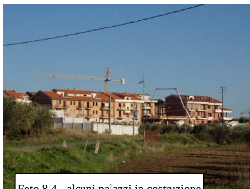
Foto 8.4 - alcuni palazzi in costruzione nel quartiere "San Matteo"
