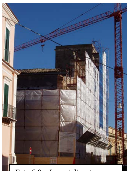
Foto 6.9 – Lavori di restauro alla Chiesa di S. Nicola
